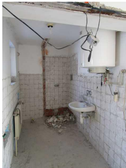
koupelna v 2. mezipatře probíhá rekonstrukce)
