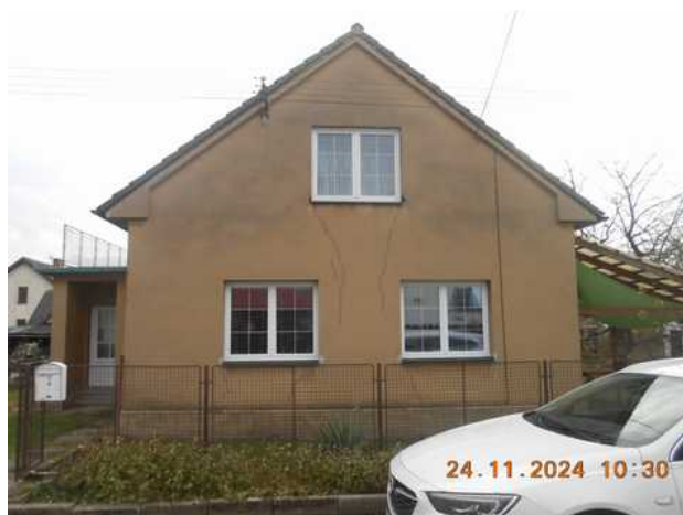
pohled z příjezdu
