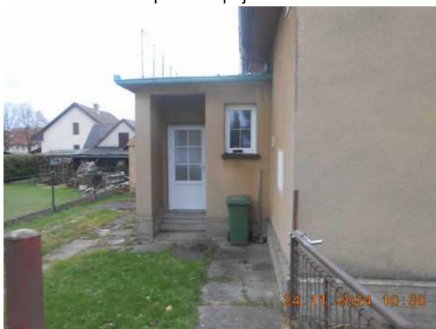
pohled z příjezdu
