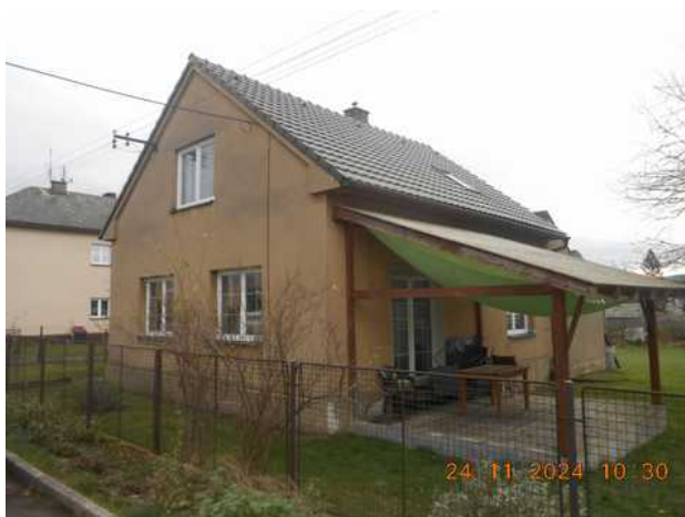
pohled z příjezdu
