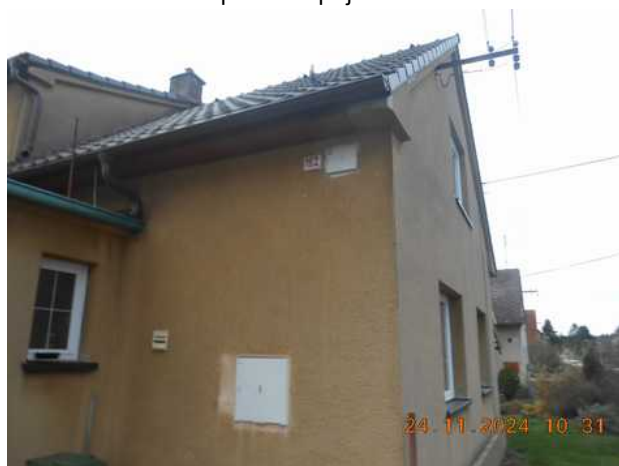
pohled z příjezdu
