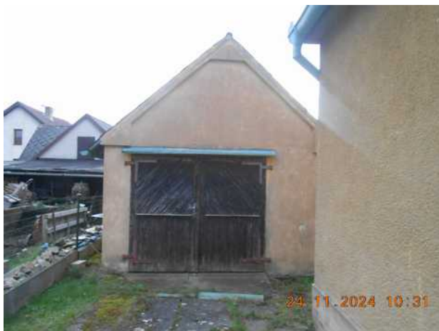
pohled z příjezdu
